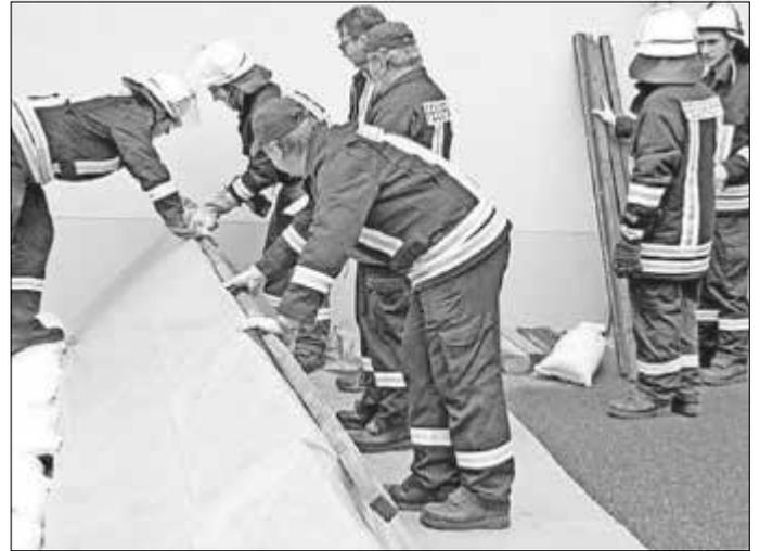
*Aufbau des Schutzwalles aus Paletten und das Befestigen der Schutzfolie*
