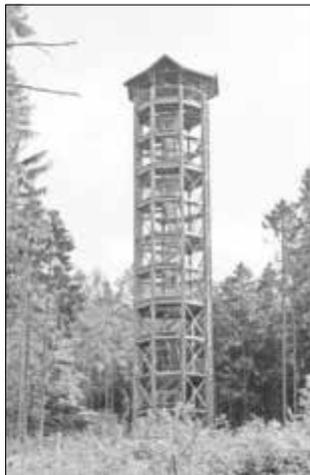
Die Sanierung des Weißbergturms in Hinterhermsdorf ist für 2017 geplant, um diesen auch zukünftig der Öffentlichkeit zugänglich halten zu können. Die Sanierung beinhaltet den Austausch beschädigter Holzbauteile und des kompletten bereits abgenutzten Bohlenbelages aller zehn Etagen, die Verblechung von Holzbauteilen zum Witterungsschutz und die komplette Erneuerung des Anstriches.
