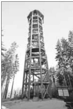
Im Jahr 2001 wurde der Weifbergturm im Sebnitzer Ortsteil Hinterhermsdorf erbaut. Nach nunmehr 14 Jahren wird die eine oder andere Sanierung am Turm erforderlich. Sehr viele der Bestandteile des hölzernen Turmes sind stark verwittert oder beschädigt. Aktuell ist der Weifbergturm noch geöffnet, aufgrund der Schäden kann aber eine sicherheitstechnisch bedingte Schließung in den nächsten beiden Jahren nicht ausgeschlossen werden.
