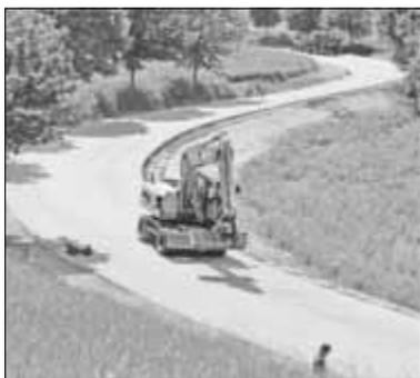
Wie unschwer zu erkennen, nimmt das Straßenbaugeschehen in Sebnitz Fahrt auf. Den Anfang machte der Ausbau der Kreisstraße S 8738 von Hertigswalde Richtung Ottendorf. In der 23. KW 2014 wurde die Schwarzdecke eingebaut. Die Fertigstellung und somit Aufhebung der Vollsperrung wird planmäßig zum 20.06.2014 erfolgen.
