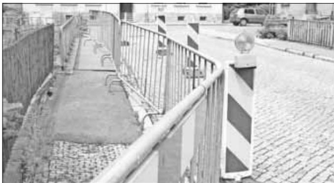
Zur Zeit läuft die Öffentliche Ausschreibung. Linksseitig der Brücke muss die Schwergewichtsmauer durch ein neues Bauwerk ersetzt werden. Zusätzlich muss der Fußbereich des Brückenwiderlagers auf Wasserspiegelhöhe saniert werden.
