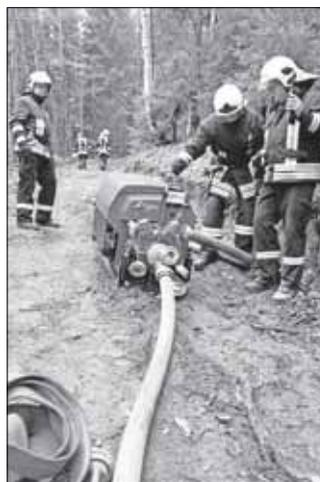
Ausbildungsthema war die Wasserförderung über lange Wegstrecke. So verlegten die drei Feuerwehren 660 m Schlauchleitung und „verbauten“ 4 Pumpen, um in der Minute 800 Liter Löschwasser von der Pietzschmühle bis auf „Richters Berg“ in Ottendorf zu fördern. 95 Meter Höhenunterschied waren dabei zu überwinden.
