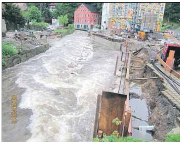
Sebnitz, Baustelle Mühlgäbchen:
