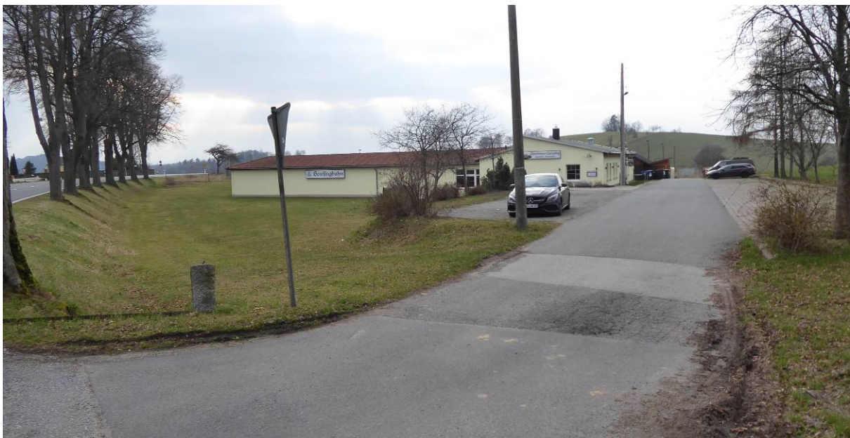
Abbildung 7: Foto Zufahrt von Osten, rechts Parkplatz mit angrenzender Baumpflanzung, links der Zufahrt Parkplatz mit angrenzender Zierpflanzung, im Hintergrund die Gaststätte, Baumreihe links an der Staatsstraße liegt außerhalb vom Plangebiet (Büro Hübner 03/ 2024)
