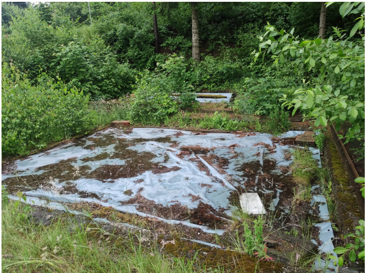
Abbildung 7: Blick in das Satzungsgebiet mit vorhandener Bodenplatte (Quelle: eigenes Foto)
