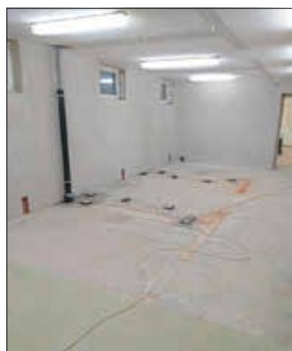
Die Bautrocknung in den Bereichen, wo der Fußboden verbleibt, läuft noch ca. 2 Wochen um ein entsprechendes Trockenergebnis zu erreichen. Die Trockenbauwände im Umkleidebereich und im Lagerraum und der Estrich im rechten Umkleideraum wurden zurückgebaut, ebenso die Heizungs- und Elektroinstallation. Der Unterputz für die Fliesenarbeiten an den Massivbauwänden wurde aufgebracht.
