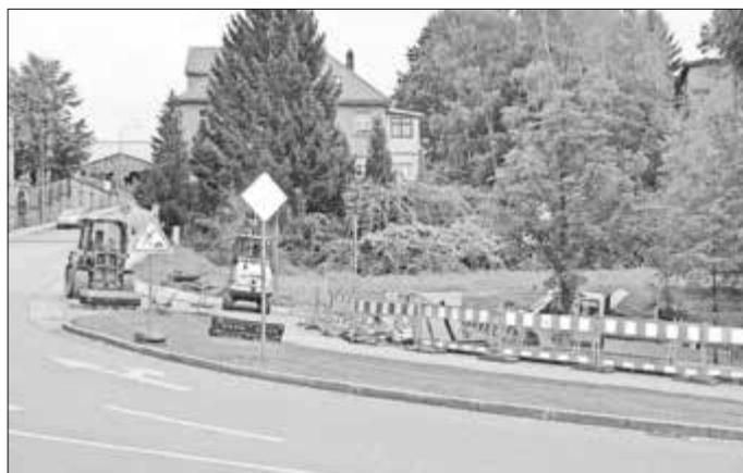
Die ENSO NETZ baut im Stadtkern von Sebnitz ein neues Breitband-Netz auf. Damit werden Übertragungsraten von 100 Mbit/s und mehr im Download möglich. Rund sechs Kilometer Glasfaserkabel werden verlegt, um mittels VDSL-Vectoring-Technologie 13 Kabelverzweiger zu erschließen.
