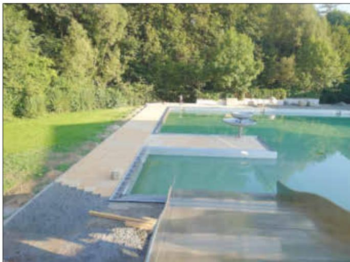
Nachdem die zur Abführung des Oberflächenwassers erforderlichen Rinnen eingesetzt wurden, konnte mit den Verlegearbeiten von hellen sandsteinfarbigen Platten begonnen werden. Diese Arbeiten werden sich jetzt noch ca. zwei Wochen hinziehen.
