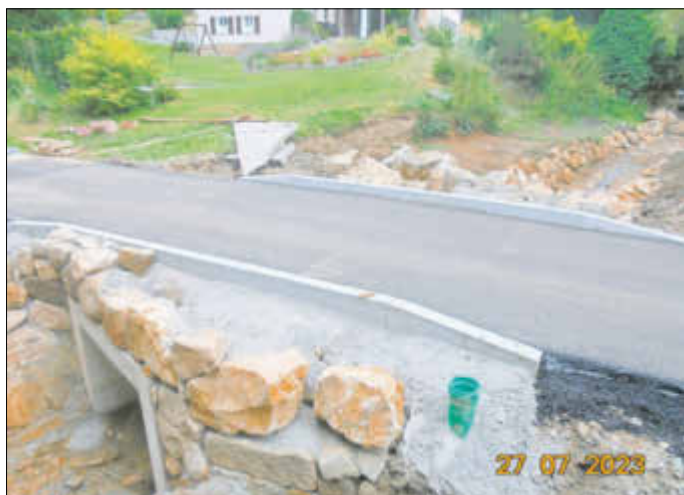
Ersatzneubau am Durchlass „Roter Busch“ an der Richtermühle
