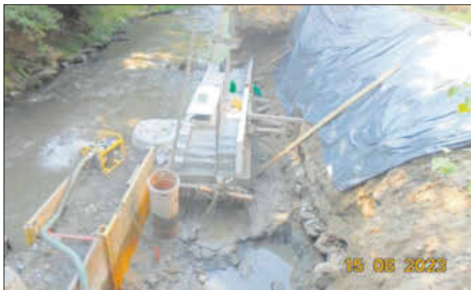
Ufermauer der Sebnitz im Bereich Haus des Gastes
