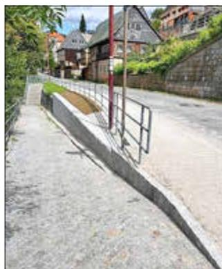
Die Hertigswalder Straße war seit Mitte Juli für den Durchgangsverkehr gesperrt. Grund waren Reparaturarbeiten zur Hang- und Gehwegsicherung im Bereich Abzweigung Wiesenweg. Die vormalig instabile Böschung zwischen Straße und Gehweg wurde ausgegraben und ein Betonfundament eingebaut. Im Anschluss wurde eine Mauer aus Granitquadersteinen errichtet und die umliegenden Bereiche angepasst.
