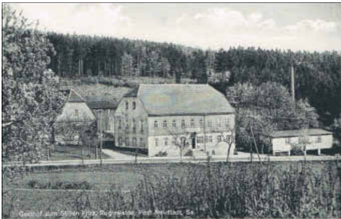
Foto: R. Trzaska, Hertigswalde Rückseite: "Schöne Gast-, Vereins- und Fremdenzimmer, schattiger Garten mit gr. Veranda, Tanz- u. Gesellschaftssaal, direkt an der Staatsstraße Neustadt-Sebnitz gelegen."
