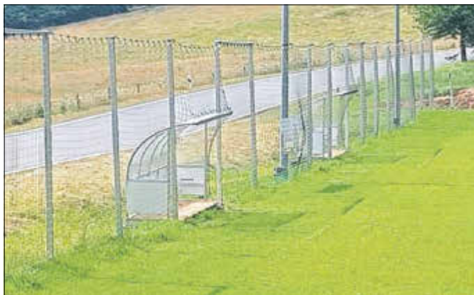
Fertig montierte Wechselbänke im Juli 2021 (Foto: R. Hempel)
