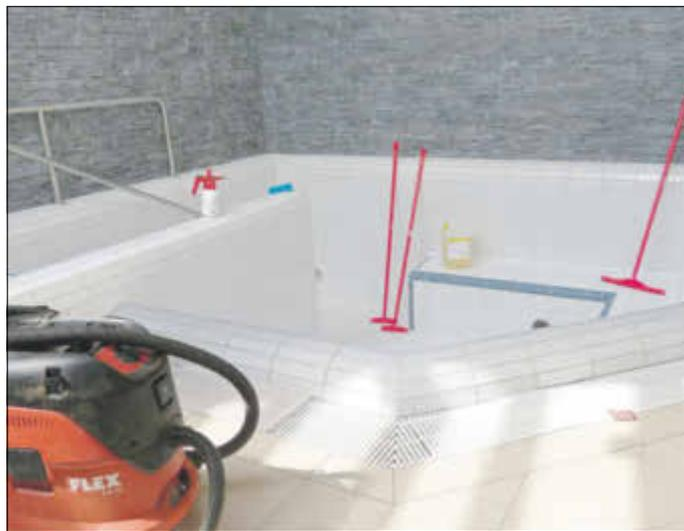
Zu den Maßnahmen in diesem Jahr gehörten neben der jährlichen Wartung und Reinigung der Lüftungsanlagen, dem ablassen der Becken und reinigen der Filteranlagen sowie der Grundreinigung aller Böden und Glasflächen auch der Austausch einiger Fliesen in der Badehalle.
