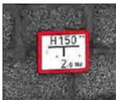
Solche Tafeln zeigen an, in welchem Abstand (auf dem Foto 2,90 m) sich in Richtung des senkrechten Striches der Hydrant zur Löschwasserentnahme befindet. Diese Tafeln befinden sich oft an Gebäuden, Mauern, Pfählen oder Zäunen.
