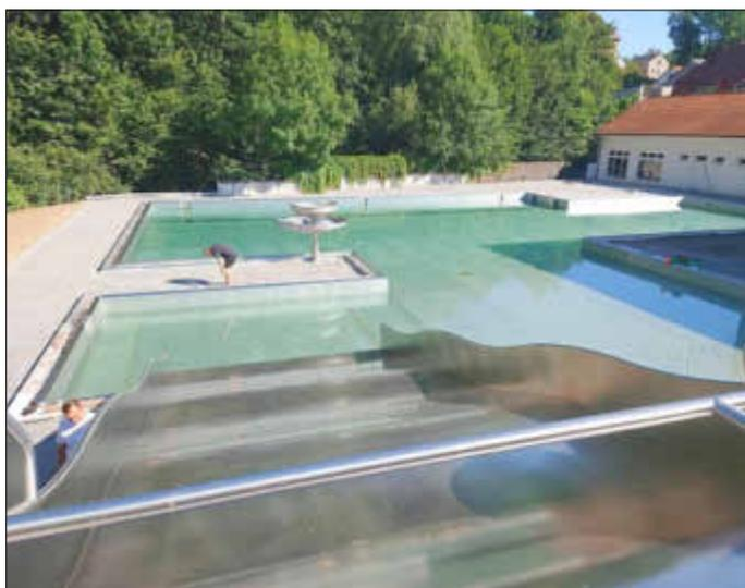
Die Schwimm- und Badebecken wurden mit Wasser befüllt. Allerdings nicht für einen beginnenden Badebetrieb. Vielmehr dient das Wasser zum Schutz des Edelstahlbeckens, welches sich bei Sonneneinstrahlung ohne eine kühlende Wasserschicht übermäßig erhitzen würde und so durch Materialausdehnungen es zu Verwerfungen und ggf. auch irreversible Schäden kommen könnte.
