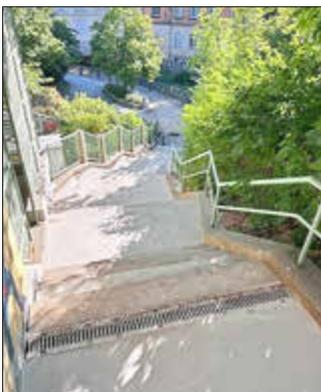
Die durch Betonzersatz angegriffene Treppenanlage zwischen Lange Straße und Kirchweg wurde in den vergangenen Tagen teilweise instandgesetzt. Dazu wurden Stufen neu versetzt und großflächig geschädigte Oberflächen gespachtelt.
