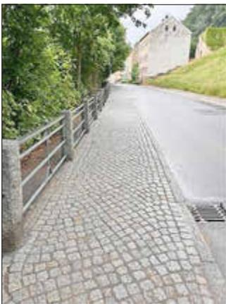
Im Juni wurde ein ca. 70 m langer Gehwegabschnitt entlang der Böhmisches Straße (S 154A) instandgesetzt und neu gepflastert. Aufgrund des abrutschenden Hangbereiches zur Sebnitz war die Gehwegrücklage aufzunehmen und ein Betonbalken zur Abstützung wurde integriert. Die Baumaßnahme begann Ende Mai und ist jetzt abgeschlossen. Während dieser Zeit stand ein Notfußweg auf der anderen Straßenseite zur Verfügung. Die Baukosten betragen ca. 50.000 Euro.
