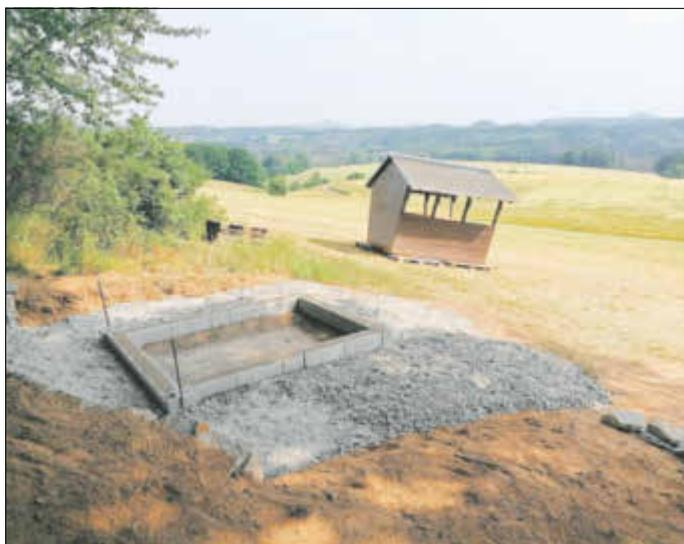
Die zweite Schutzhütte auf der Hohen Straße wurde auf Schaltungssteine gesetzt, so dass das Holz nicht mehr direkt auf dem Boden steht. Der Eingang der Schutzhütte wurde umgestaltet. Rund um die Hütte wurden „Wassersteine“ zur Hangsicherung gesetzt.
