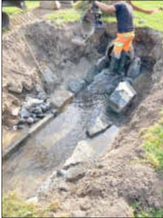
Ein Mitarbeiter der Sebnitztalbau GmbH bei der Böschungsherstellung
