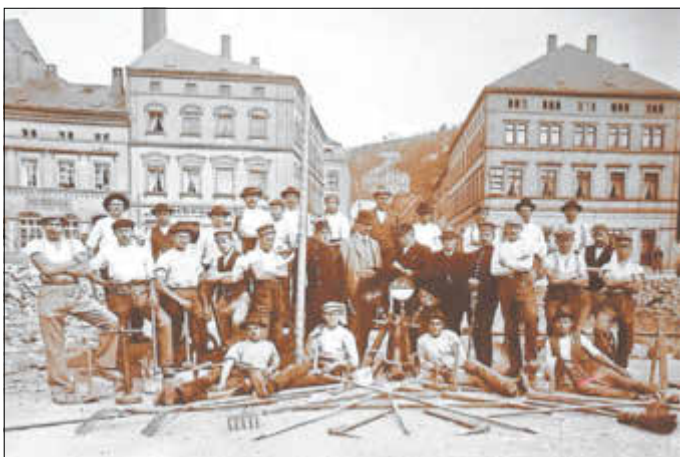
Bauarbeiter beim Pflastern des Marktes
