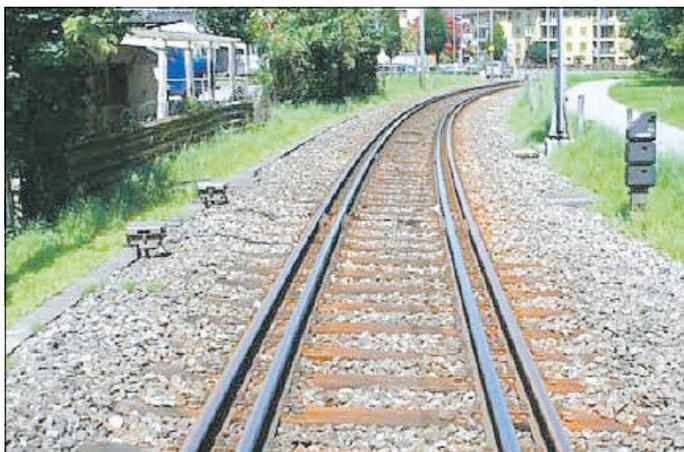
Eine Möglichkeit wäre der Ausbau im Bestand der Gleisanlage und kombinierbar mit der Deutschen Bahn (3- bzw. 4-Schiengleis).
