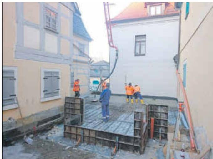
Die Betonierarbeiten zum Herstellen des Fundaments zwischen den beiden Gebäuden, wo sich dann einmal der neue Eingangsbereich befinden wird, sind bereits abgeschlossen.
