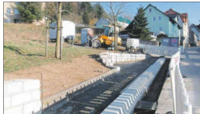
Bereits im vergangenen Jahr wurden zwei neue Bushaltestellen in Sebnitz errichtet, eine an der Hohnsteiner Straße, kurz vor dem Kreisverkehr Brückenschänke und eine an der S 154, gegenüber dem Parkplatz der Firma WEKA. Der Ausbau erfolgte barrierefrei mit Sonderborden sowie einem Blindenleitsystem. Diese drei neuen Haltstellen wurden erforderlich, da die Busse eine veränderte Fahrtroute aufgrund der neuen Straßenführung an der Gartenstraße über den Nationalparkbahnhof Sebnitz nehmen können.
