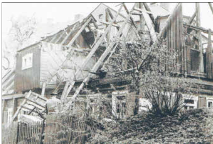
Abbrucharbeiten am Haus Friedhofstraße 11 im Jahr 1971 (Foto: Archiv, U. Kaufer)
