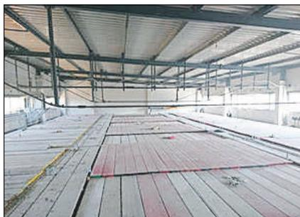
Die alte Unterhangdecke in der Turnhalle wurde entfernt. Derzeit erfolgt die Montage der neuen Unterhangdecke.
