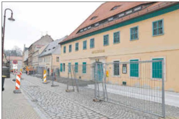
Um die Baumaßnahme abzusichern, ist eine halbseitige Sperrung mit Fahrbahneinengung auf 2,2 m erforderlich. Das bedeutet, dass tatsächlich breitere Fahrzeuge in dieser Zeit
