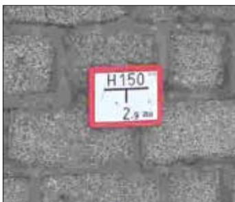
*Diese Tafel befindet sich an der Schandauer Straße. Darauf ist ersichtlich, dass sich im Abstand von 2,90 m in Richtung des senkrechten Striches der Hydrant zur Löschwasserentnahme befindet.*
