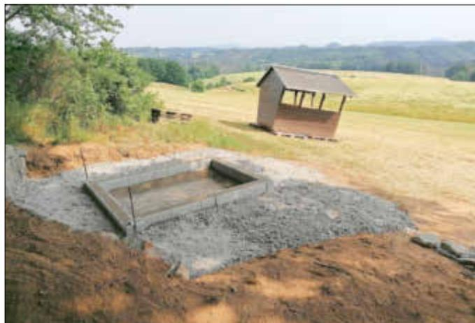
Die zweite Schutzhütte auf der Hohen Straße wurde auf Schaltungssteine gesetzt, so dass das Holz nicht mehr direkt auf dem Boden steht. Der Eingang der Schutzhütte wurde umgestaltet. Rund um die Hütte wurden „Wassersteine“ zur Hangsicherung gesetzt. Die Kosten für die beiden Maßnahmen betragen ca. 9.540 Euro.
