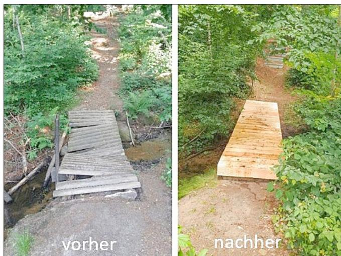
Am Dr.-Alfred-Meiche-Weg – Wachberg Richtung Weißberg – wurde eine alte Stufenanlage entfernt sowie Alpineisen und Halteeisen eingebaut. Des Weiteren wurde das Gewässer und die Brückenanlage geräumt und die Brücke mit einer neuen Lauffläche ausgestattet. In diesem Zusammenhang wurden auf dem Weg Strauchwucherungen entfernt, sodass der Weg wieder gut begehbar ist. Die Kosten für diese Maßnahmen betragen rund 2.450 Euro.
