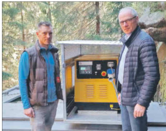
Die Firma Hanno Schmidt, Geschäftsführer Marc Wenzel, zeigt Oberbürgermeister Mike Ruckh die neuste Errungenschaft an der Kahnfahrt Obere Schleuse: ein gasbetriebenes Notstromaggregat.
