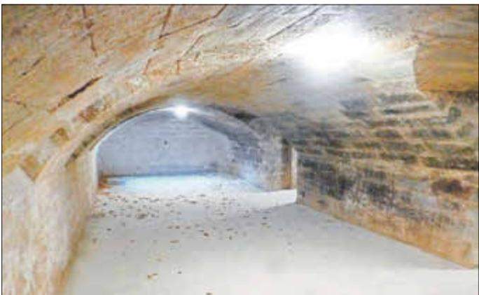
*Ausbau und Überdachung des historischen Gewölbekellers des Gasthofes. Der Rand der Überdachung wurden aus Sandsteinquadern errichtet, die während des Abbruchs gesichert wurden – Fertigstellung im Oktober 2018*
